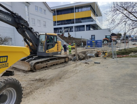
Die Umbauarbeiten Foto: Gemeinde
